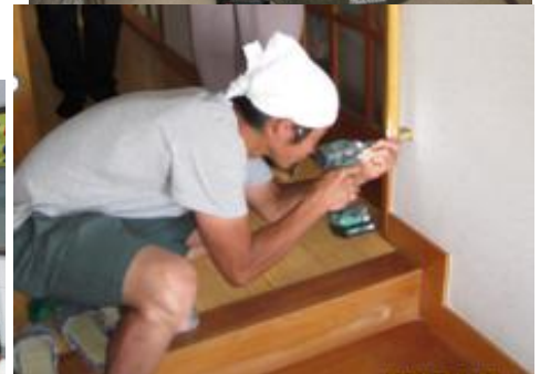
トイレの敷居を修繕(上)
